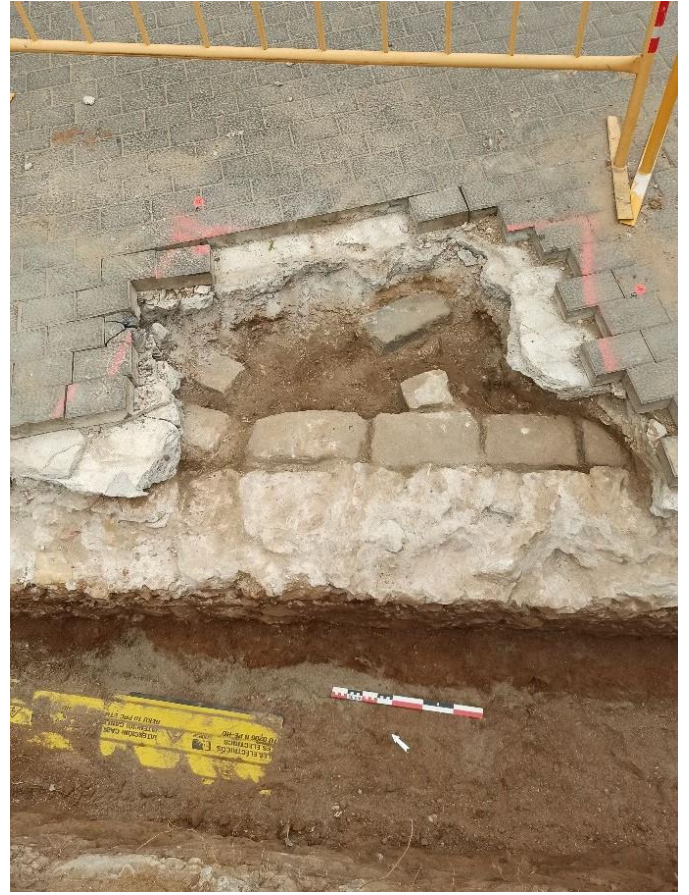
Fig. 13 Detall del sondeig de MR425. Es pot veure la vorada moderna adossada al mur.
