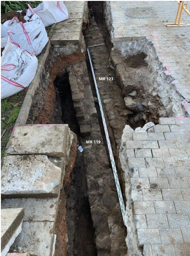
Fig. 4 Rasa 100, cantonada Oest del Mercat de Sant Martí de Provençals. MR124 i MR119
